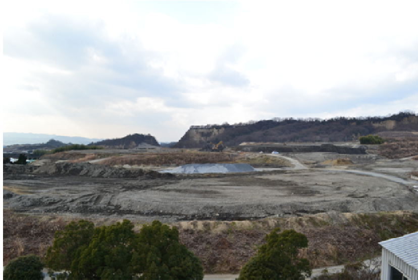
敷地面積84,480㎡(京都府城陽市)
